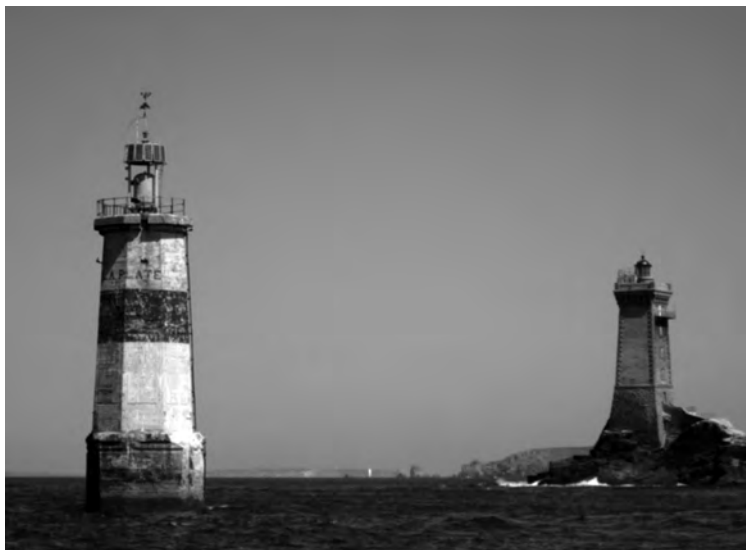
La Tourelle de la Plate et le Phare de la Vieille du Raz-de-Sein
